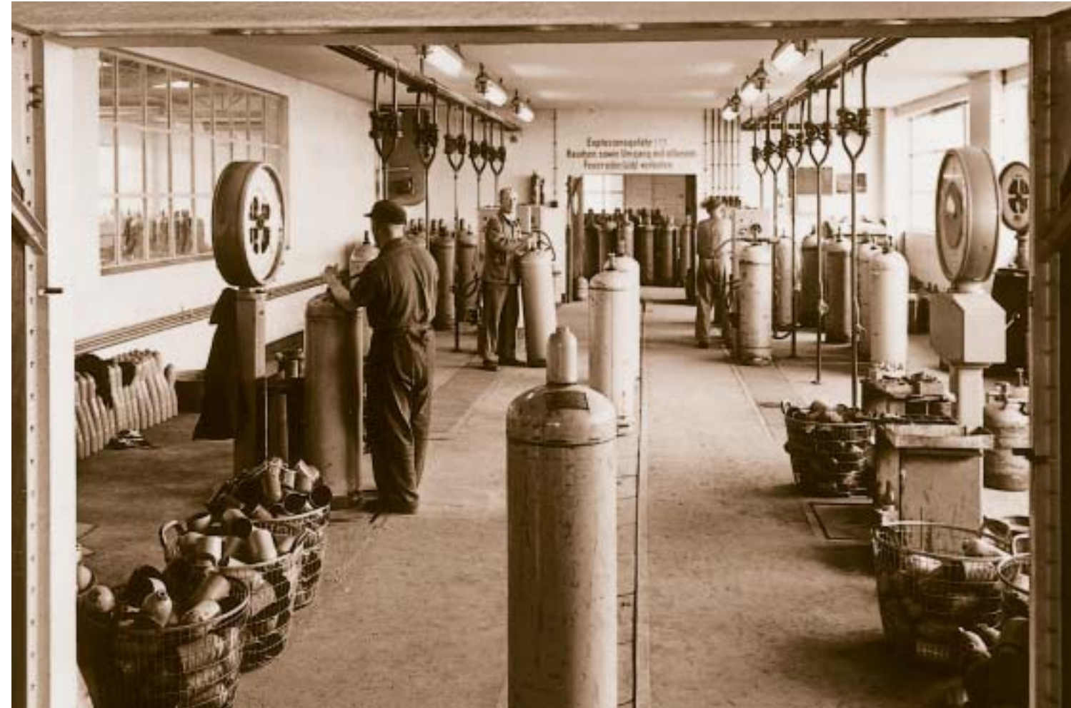
Schon 1961 löste ein großzügiger Neubau die ursprüngliche Füllstelle ab.
